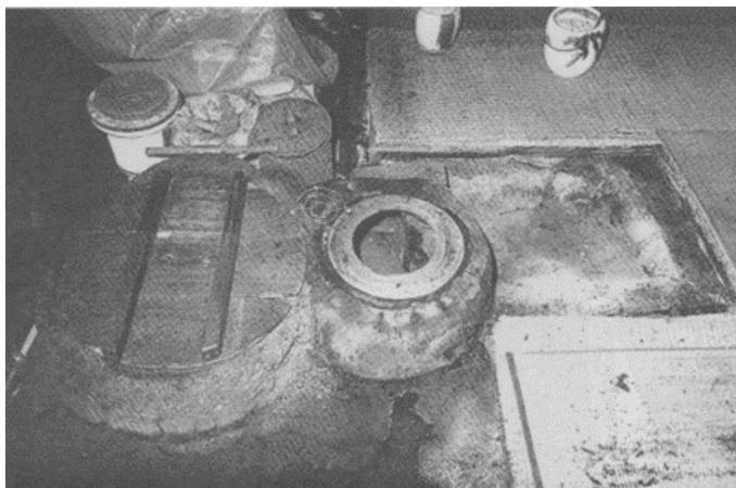
▲湖北地域（旧西浅井町）のかまど 土間とダイドコロをまたぎ、イロリと合体。イロリは比較的寒冷的な地域に見られ、栗東市域ではほとんどない。気温による住まい方から、こうしたかまどの設置がなされているのだろう。 （写真は『滋賀県の近世民家』（滋賀県教育委員会 1998 年）より転載）
